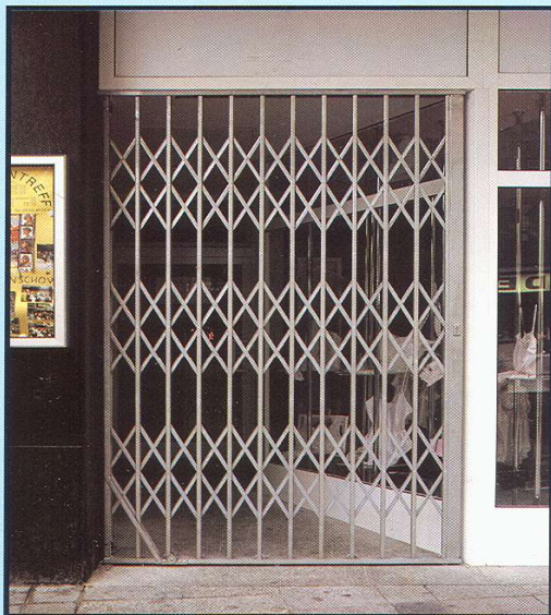
Sicherung eines Eingangs
