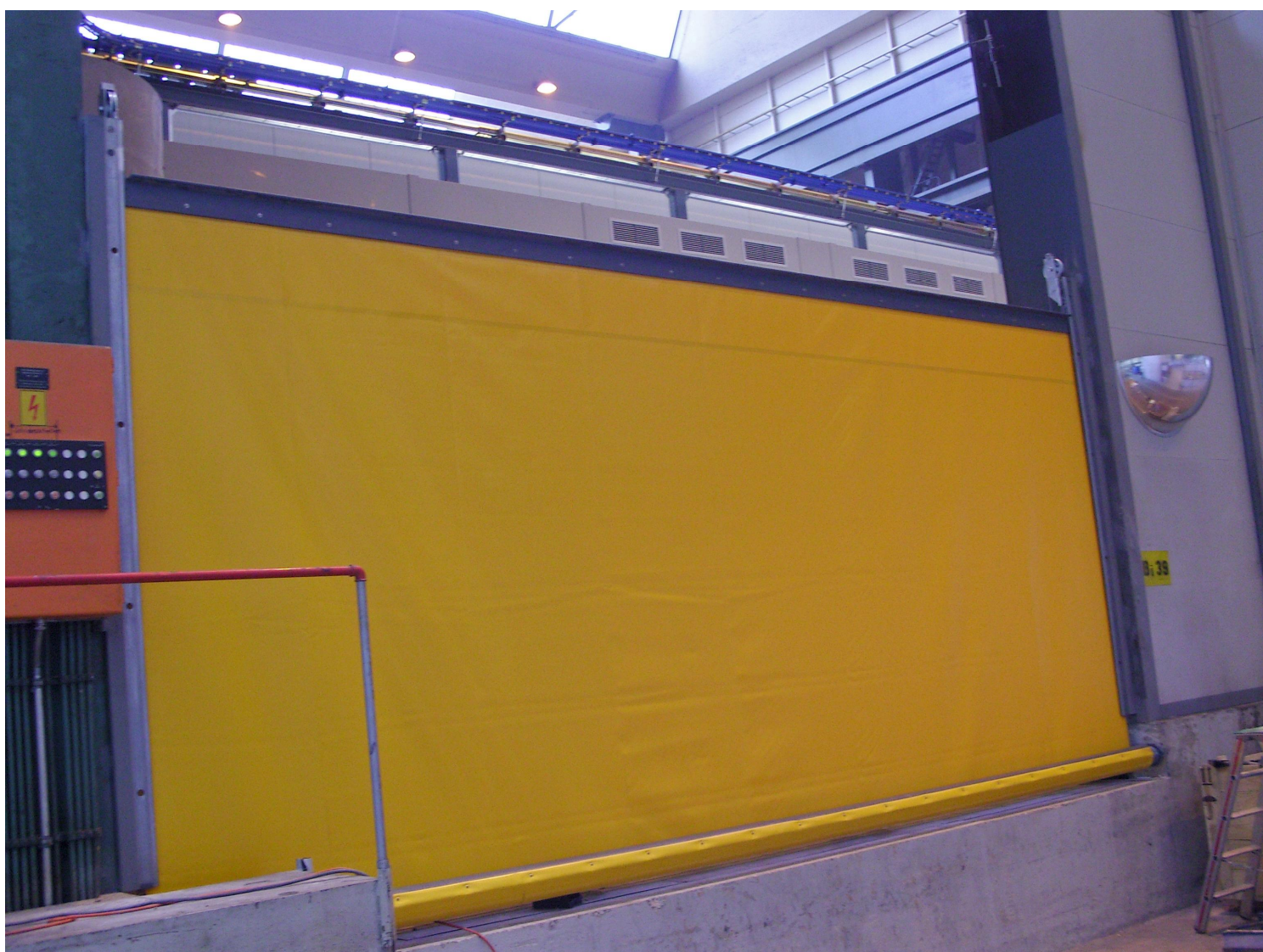
Rolltor mit unterer Rohrwalze und Antrieb im Boden
