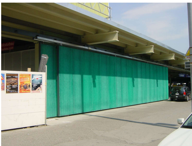
Teleskop-Schiebetore S-Bahnhof Zürich
