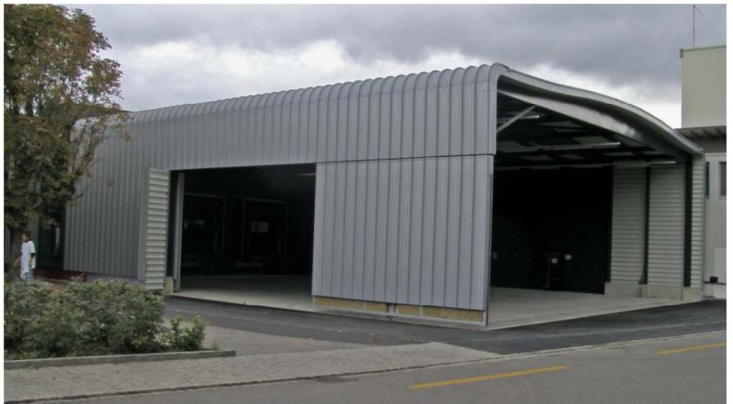
**Spezialkonstruktion mit 2 Schiebetorflügel versetzt**
