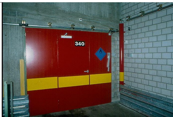
Brandschutz - Schiebetore EI 30 mit manueller Schliessung (Seilzug und Gegengewicht)
